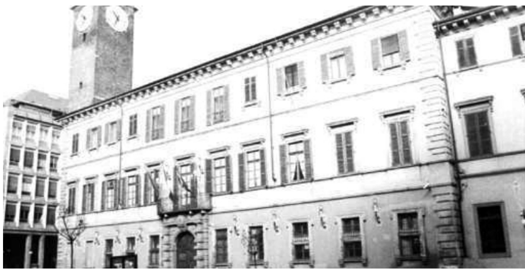
VERTICE Palazzo Natta, sede di Provincia e Prefettura, ha affrontato il problema del vandalismo nelle scuole
